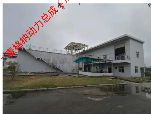
二期非磷化废水处理站
