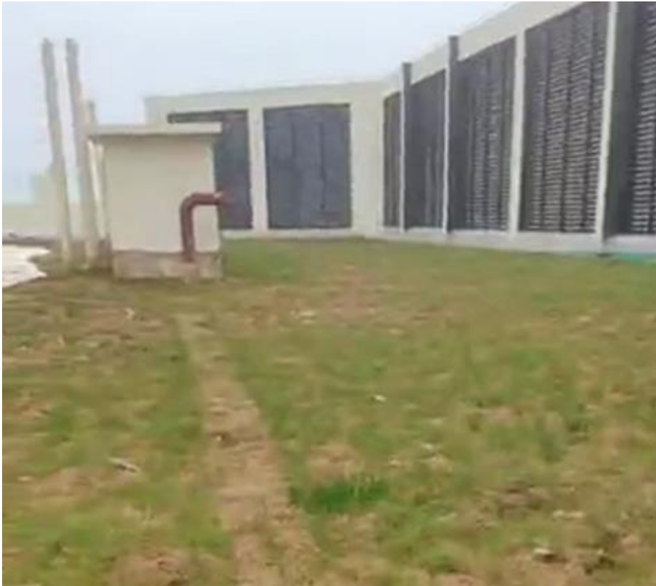
主体工程区（2020年12月）
