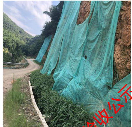
图片 2 道路排水沟及护坡播撒草籽
