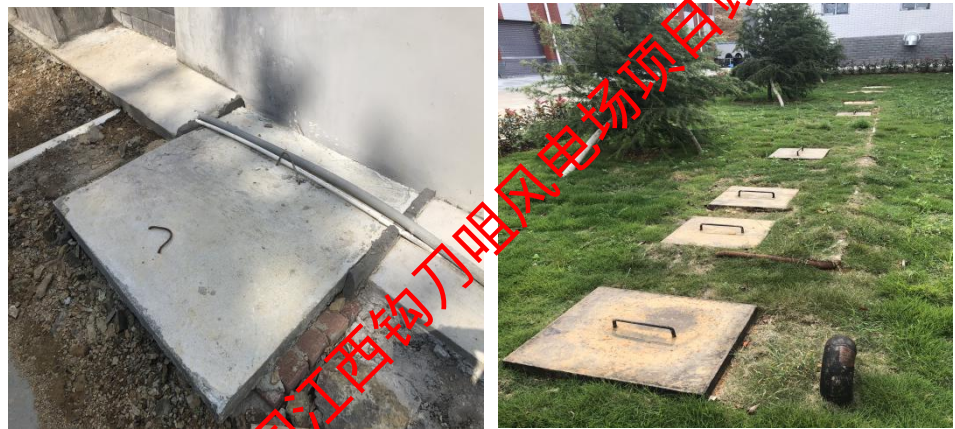
图片 10 隔油池 图片 11 一体化污水设施
