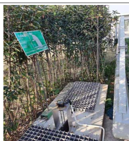
废水排放口（进入化粪池）
