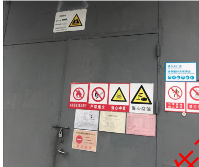
危险废物暂存间
