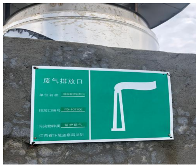
锅炉废气排放口
