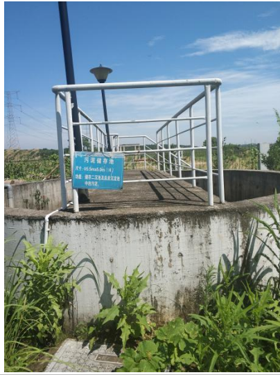
污泥浓缩池（储存池）
