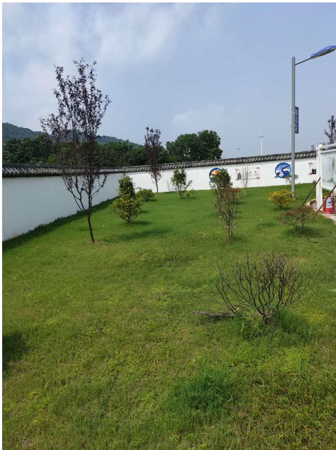
主体工程区（2020年7月）
