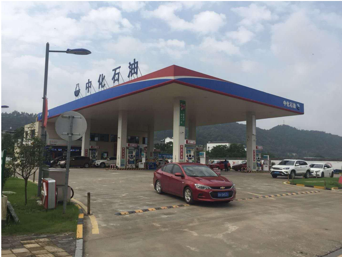
主体工程区（2020 年 7 月）
