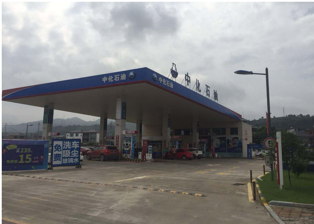
主体工程区（2020 年 7 月）
